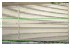
多段施工では中間部に胴縁のラインが入ります。
